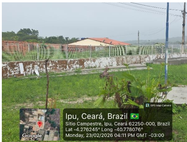
Figura 07: Postes e anéis em concreto armado recebidos na Escola Antônio Otaviano de Melo
