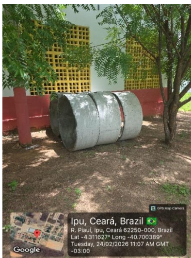
Figura 06: Tubos de concreto armado para águas pluviais recebidos na EMEB Nossa Senhora de Fátima
